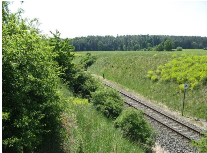
Abbildung 11: Bahnböschungen westlich angrenzend
